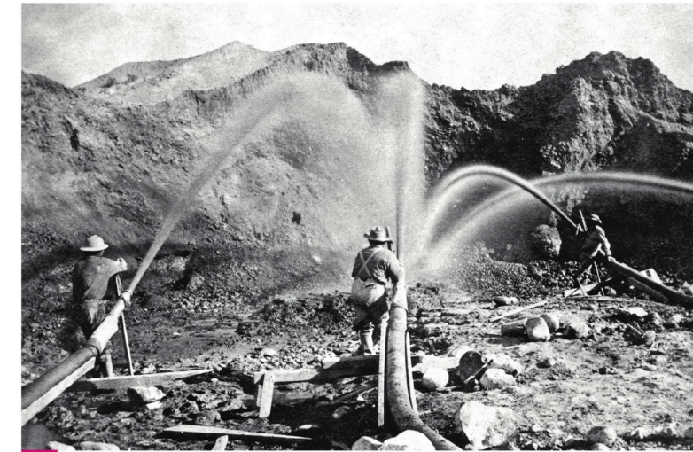
4 Extraction hydraulique d'or dans l'Ouest américain (en 1866)
