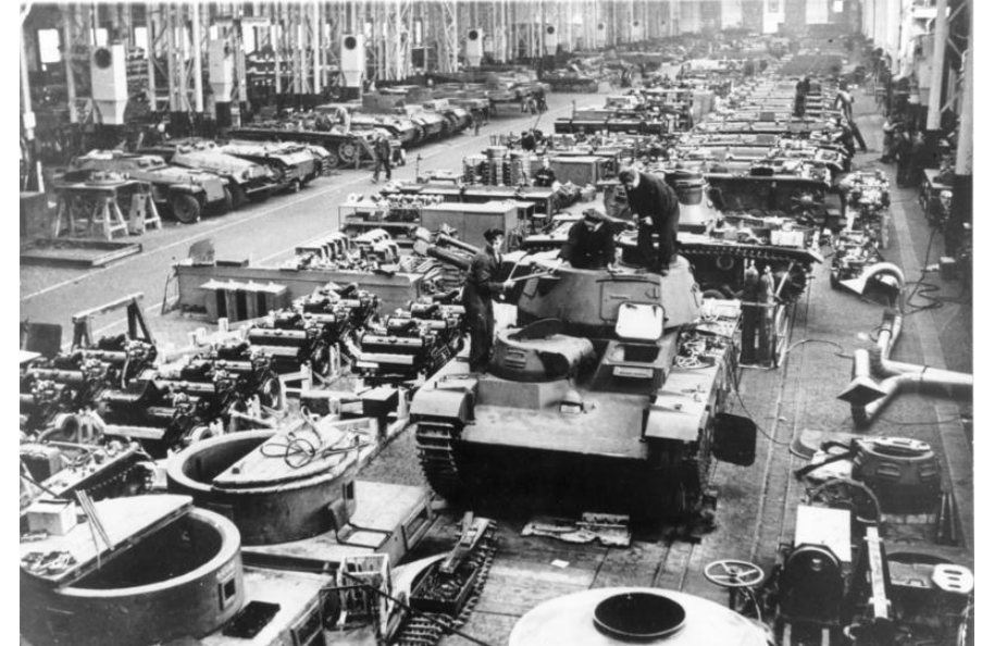
Ligne de montage du char d'assaut allemand Neubaufahrzeug
